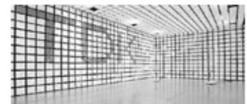
电波吸收体/电波暗室
